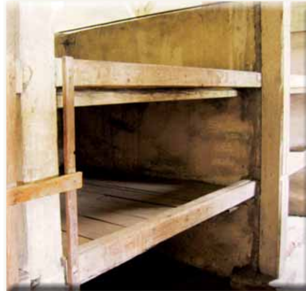
Espacio para dormir, 8 por hueco, 24 en las tres literas superpuestas.
